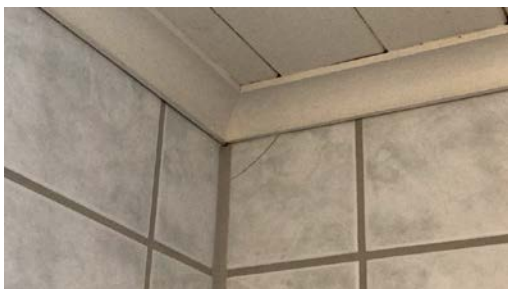
Eksempel på sprekk i flis.
