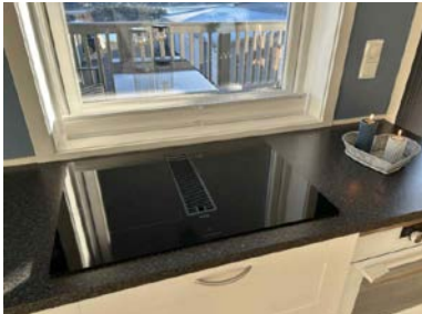
Utsnitt avtrekk, kullfilter integrert i platetopp.
