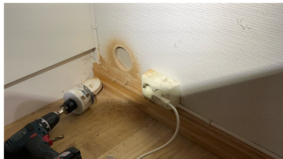
Hulltaking er utført i tilstøtende vegg mot våtsone dusj. Det var bakenforliggende gipsplate i vegg, det er ikke boret gjennom denne og inspisert inn i veggkonstruksjonen på grunn av risikoen for svekkelse av eventuell brannsjakt/brannskille.
