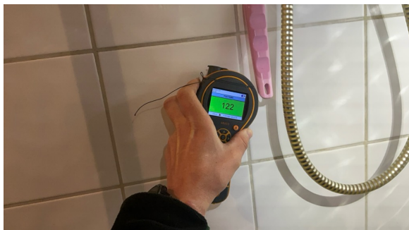
Fuktsøk viste normale verdier.
