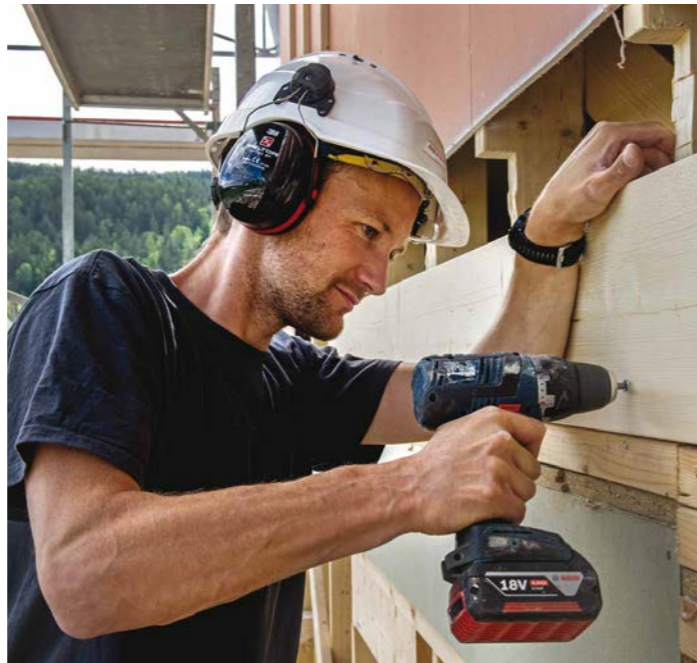
Byggingen Overtagelse Sikkerhet på byggeplassen
