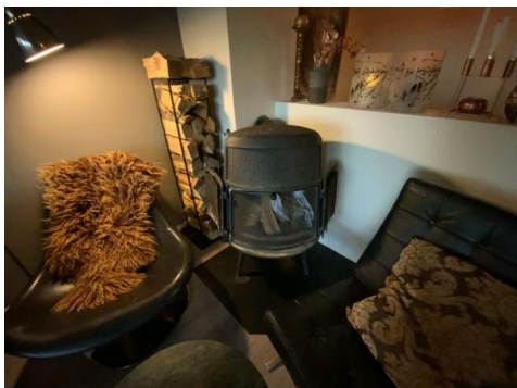
Besiktelse av ildsted.
