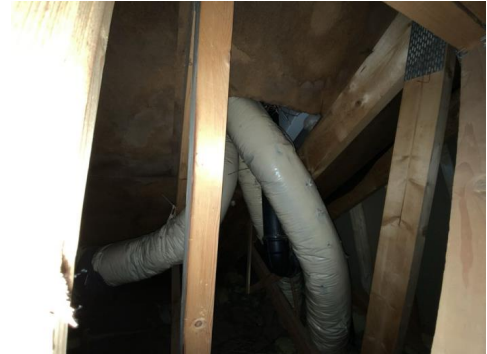
Kontroll rundt rørgjennomføringer. Noe missfarget undertak.
