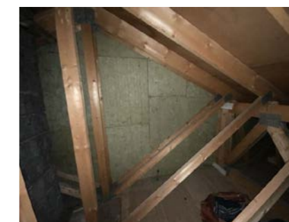
Kontroll rundt rørgjennomføringer. Noe missfarget undertak.
