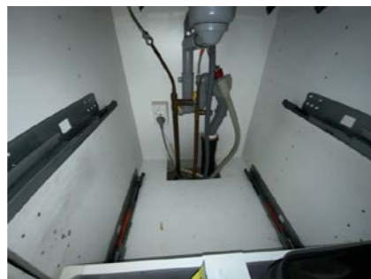
Besiktigelse av røropplegg.
