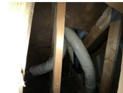
Kontroll rundt rørgjennomføringer. Noe missfarget undertak.
