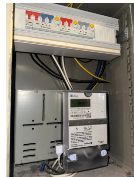
Sikringsskap med automatsikringer.
