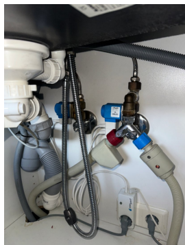
Røropplegg i kjøkkenbenk med Waterguard
