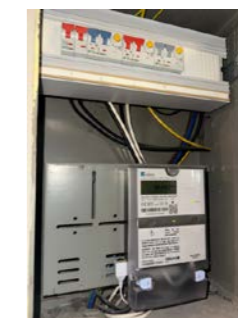
Sikringsskap med automatsikringer.
