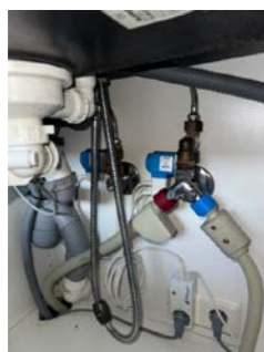
Rørapplegg i kjøkkenbenk med Waterguard
