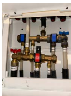
Rørapplegg i kjøkkenbenk med Waterguard
