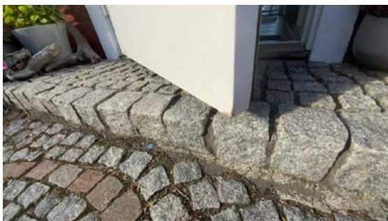
Noe skader på inngangsdør.
