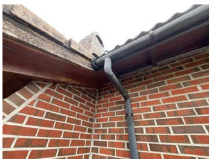
Takrenner og nedløp i plast fra byggeår.
