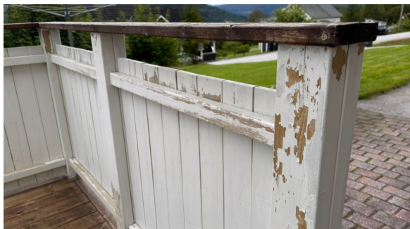
Værslitt rekkverk
