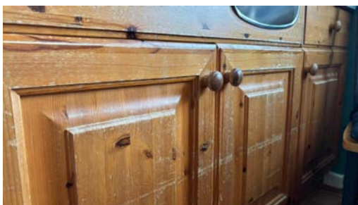
Stedvis større slitasje på skapfrontene
