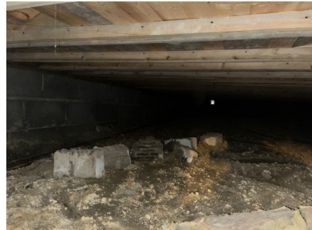
Oversiktsbilde fra kryperom.
