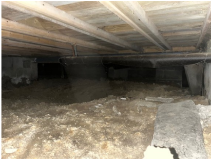
Oversiktsbilde fra kryperom.
