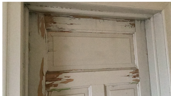
Tredør i opprinnelig del.
