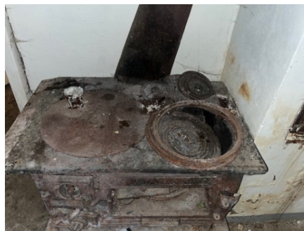
Skader på vedovn i kjeller.
