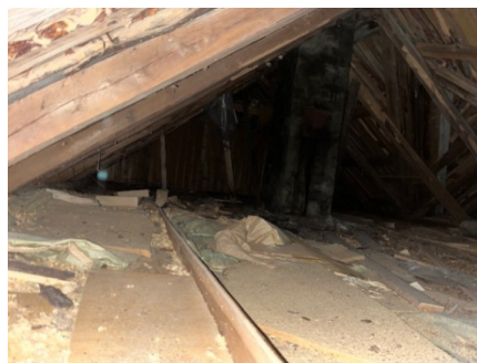
Oversikt fra loft på opprinnelig del.
