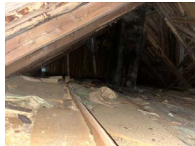
Oversikt fra loft på opprinnelig del.
