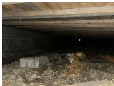
Oversiktsbilde fra kryperom.
