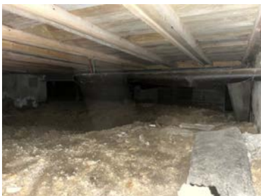
Oversiktsbilde fra kryperom.
