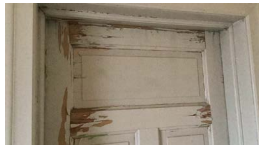
Tredør i opprinnelig del.
