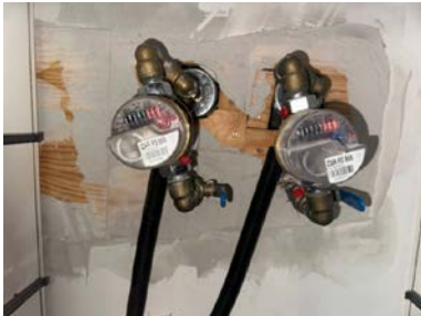
Stoppekran plassert på kjøkken
