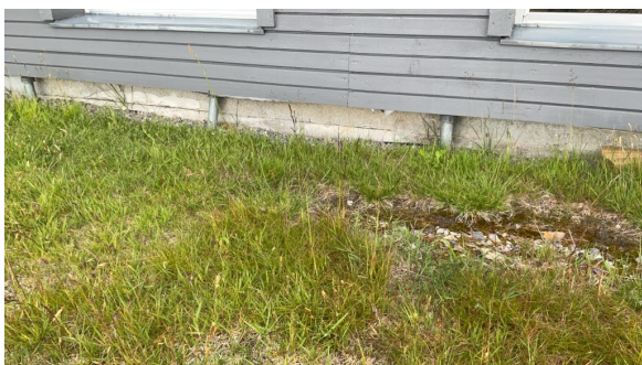
Det er lagt inn lufting i grunnen.
