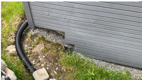
Lav høyde mellom grunnen og kledning, risiko for skader. Anbefalt høyde mellom terreng og kledning er 30 cm.
