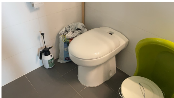
Biotoalett plassert på bad.
