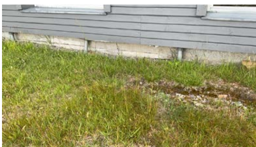
Det er lagt inn lufting i grunnen.
