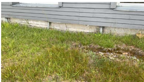
Det er lagt inn lufting i grunnen.
