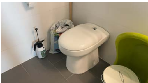
Biotoalett plassert på bad.
