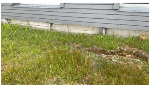
Det er lagt inn lufting i grunnen.
