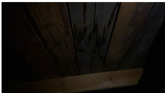
Fuktskjolder i undertakbord.
