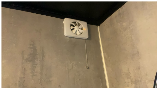
Elektrisk styrt avtrekksvifte.
