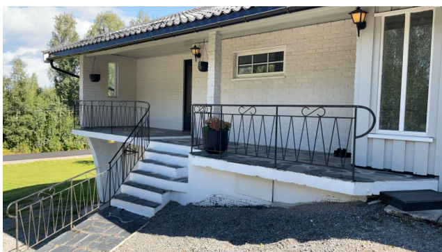
Terrasse ved inngangsparti.
