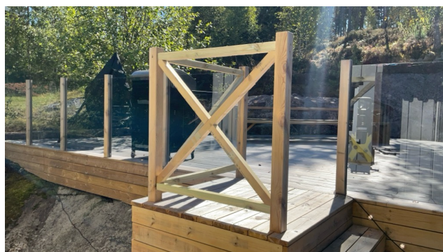
For store åpninger i rekkverk.
