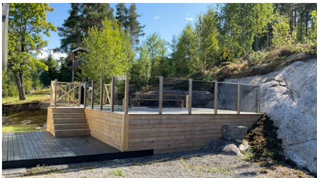
Stor terrasse med glassrekkverk bygget på fjell.
