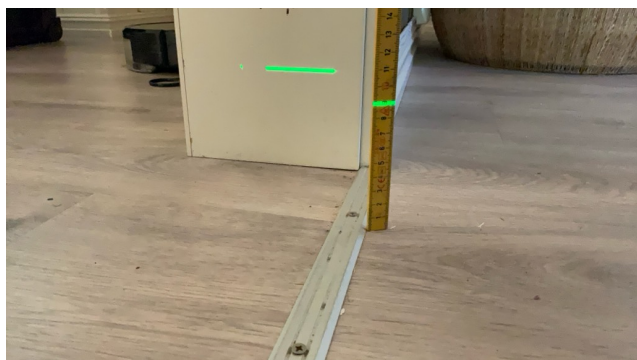
Det er målt 9cm diagonalt igjennom hele rommet fra utgangspunkt.
