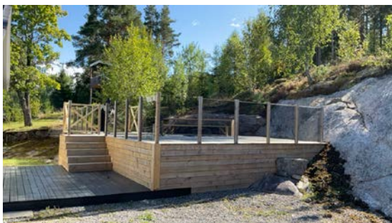
Stor terrasse med glassrekkverk bygget på fjell.
