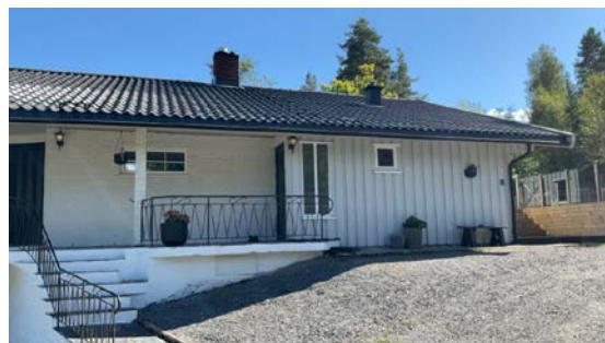
Tømmermannskledning og teglsteinfasade.
