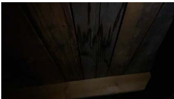
Fuktskjolder i undertakbord.
