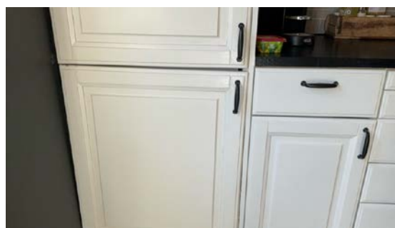
Eksempel på skjevheter på kjølfryseskap.
