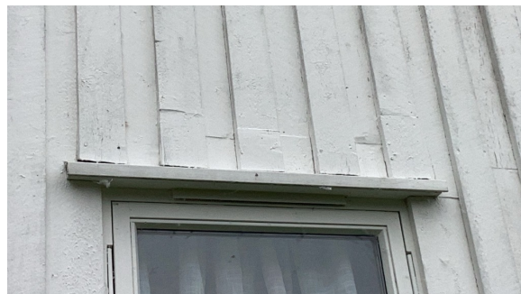
Eksempel på mindre utskiftinger av treverk.
