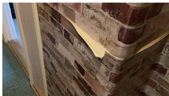
Tapet på pipe løsner.
