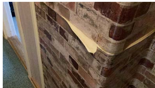
Tapet på pipe løsner.
