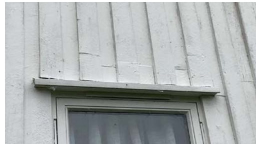
Eksempel på mindre utskiftinger av treverk.
