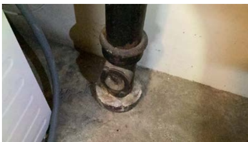
Stakepunkt i kjeller.
