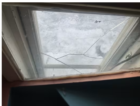
I trappeoppgang til 2.etg fra 83
