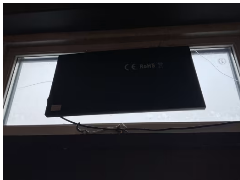
Sprekt glass i inngangspartiet til Nikita
