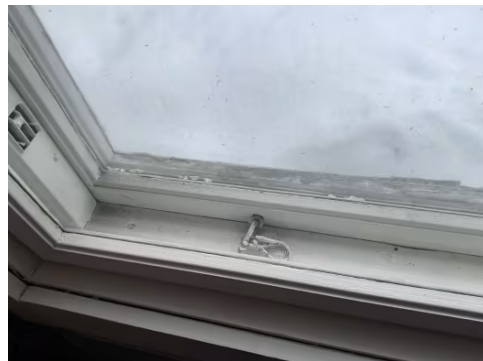
Alle vinduer i lokalet Thaimassasje er av eldre type som dette.
