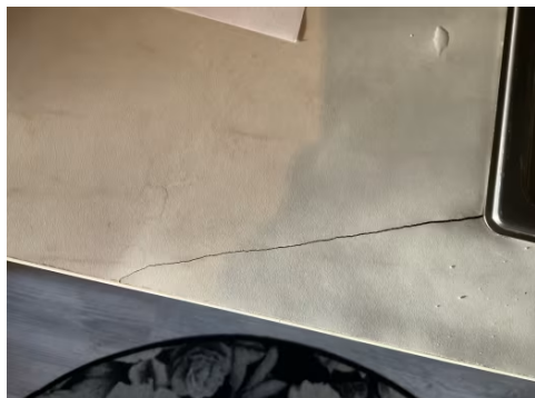
Sprekk i benkeplate
