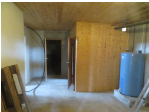
Del av innvendige overflater.
