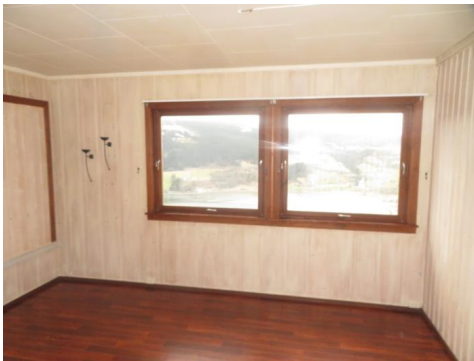
Del av innvendige overflater.
