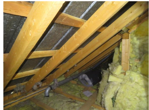
Takkonstruksjon uten undertak - undersiden av takplater ses.
