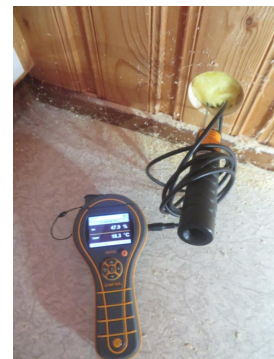
Fuktsøk relativ fuktighet - Naturlige utslag - ingen forhøyede fuktverdier.
