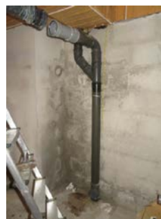
Synlige partier med fuktopptrekk/fuktgjennomslag.
