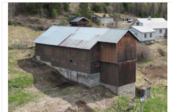
Driftsbygning fra 1965 med tilbygd silodel ut på ytre gavl ca 1980.
