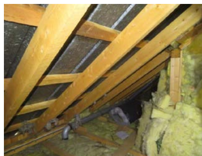
Takkonstruksjon uten undertak - undersiden av takplater ses.
