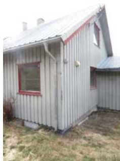
Nedløpsrør ført til nedgravd drenerør til terreng.
