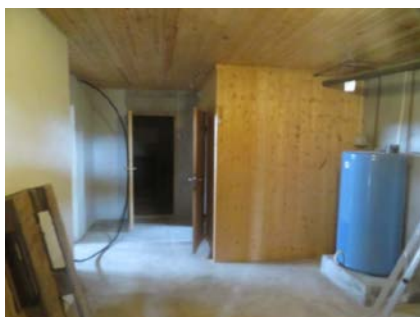
Del av innvendige overflater.
