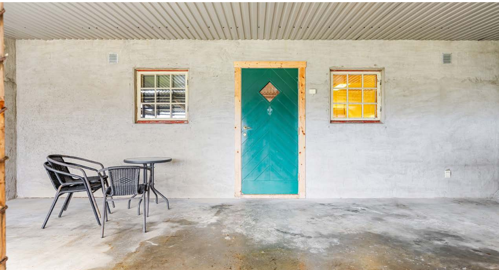
Overbygd uteplass i underetasjen med støpt plate på ca. 32m 2 .
