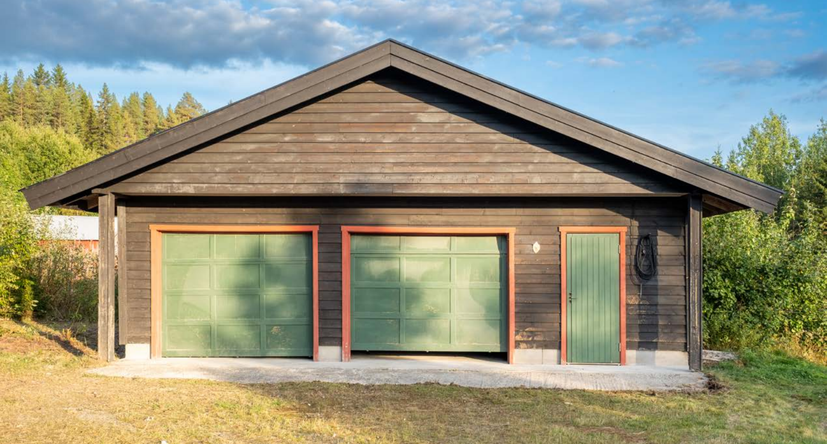
Stor dobbeltgarasje på 50m 2 med 2 porter. Ved garasjen er det også en hytte og en lekestue.
