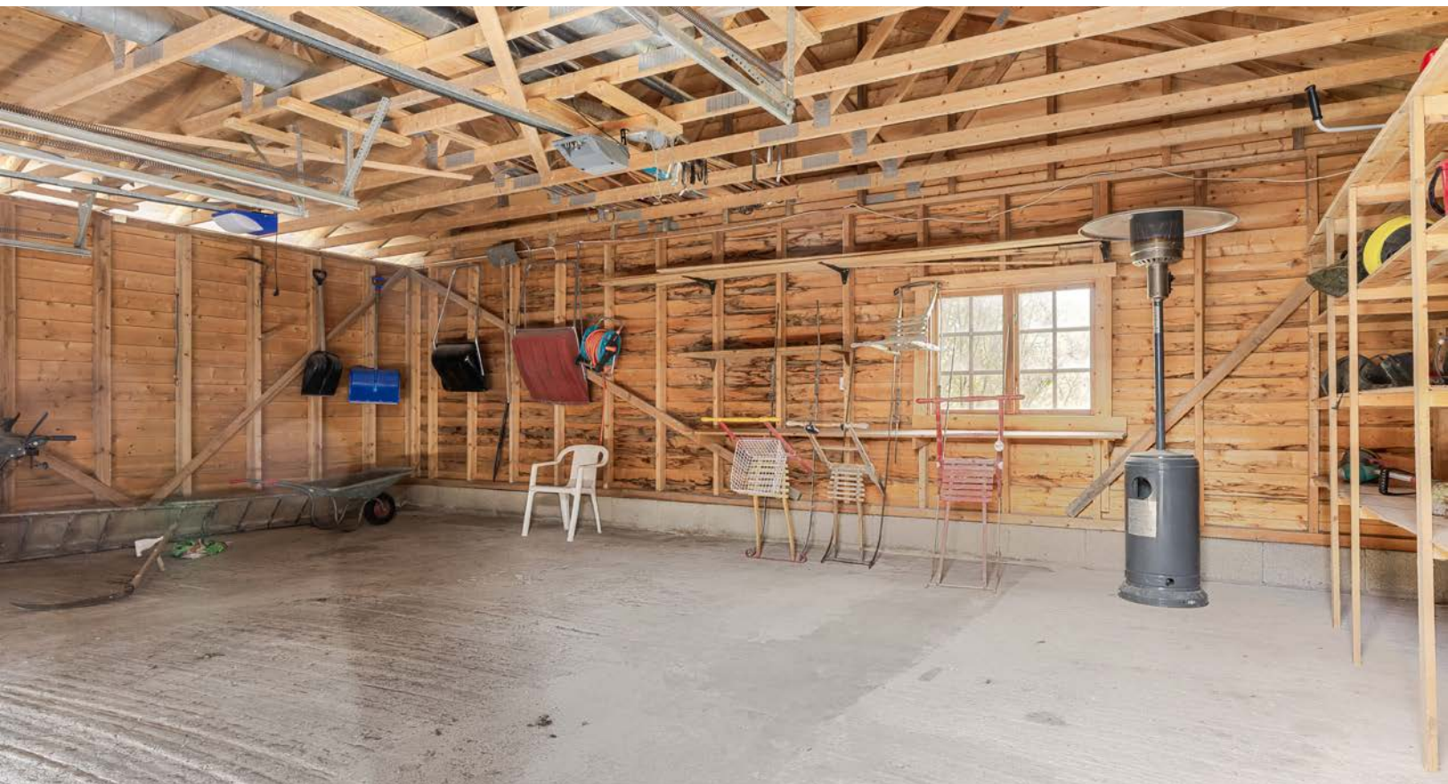
Garasje er oppført på støpt plate mot grunn med ringmur av lettklinkerblokker. Yttervegger av uisolert bindingsverk av tre, utvendig kledd med liggende trekledning. Saltak av trekonstruksjoner, tekket med takplater av metall.
