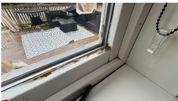
Det er tegn til innvendig kondensering på vinduer.
