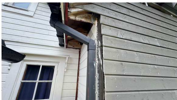
Det mangler hjørnekasser på deler av hytta.
