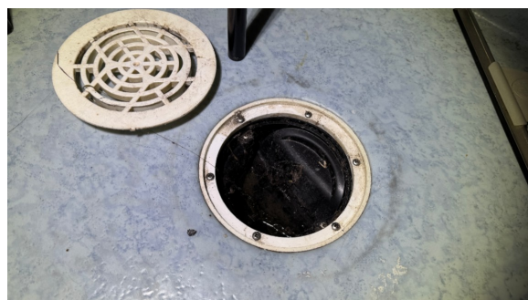
Kontroll av sluk.
