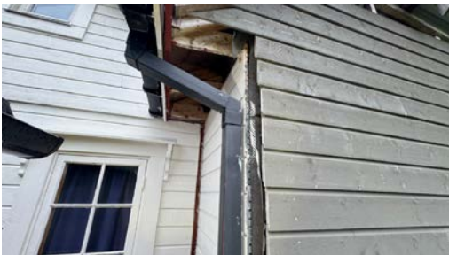
Det mangler hjørnekasser på deler av hytta.
