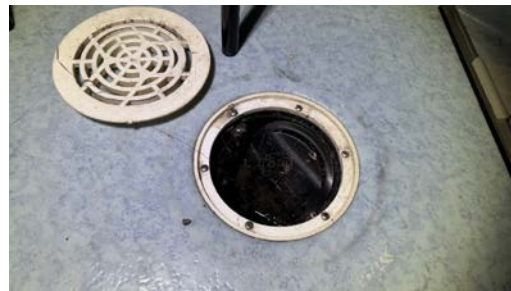
Kontroll av sluk.
