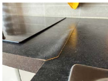
Skjøt på benkeplate.
