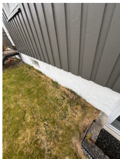
Knotteplast er stedvis under terreng.
