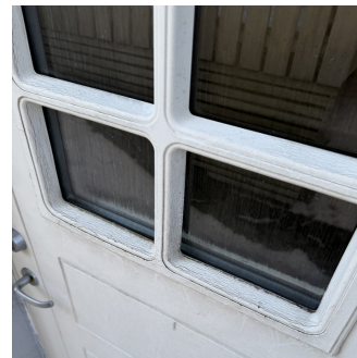
Sprekker i maling/trevirke i srosse på dør
