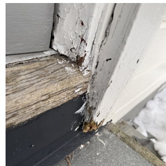
Sprekker i maling/trevirke i srosse på dør
