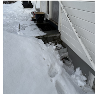
Platting og trapp på sørveggen
