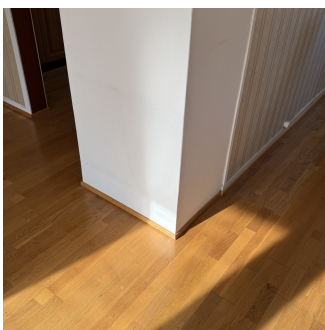
Parkett for nært pipe i 2 etasje
