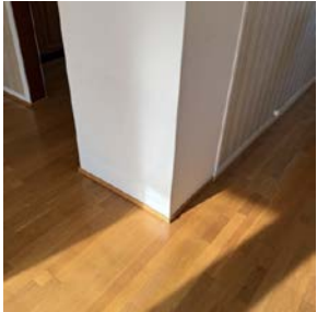
Parkett for nært pipe i 2 etasje
