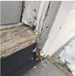
Sprekker i maling/trevirke i srosse på dør
