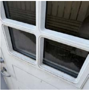
Sprekker i maling/trevirke i srosse på dør
