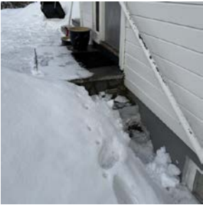
Platting og trapp på sørveggen
