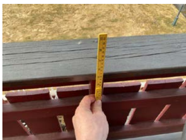
Rekkverk målt til 0,9 m.
