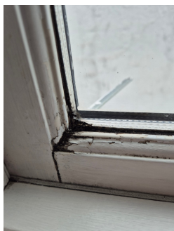
Tegn til innvendig konsensering.
