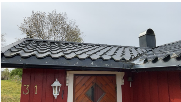
Misfarginger og ujevnheter i gradrenne.
