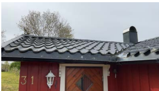
Misfarging og ujevnheter i gradrenne.
