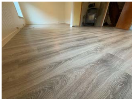
Bilde viser gulv i stue 1 etasje.
