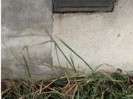
Eksempel på utvendig skråriss.
