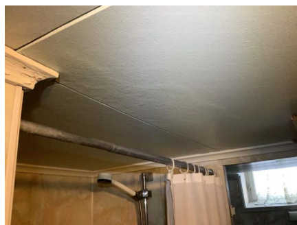
Fuktskadet himlingsplate.
