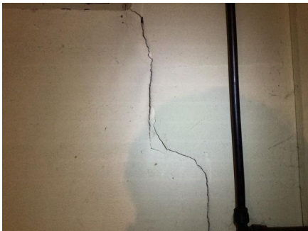
Eksempel på innvendig skråriss.
