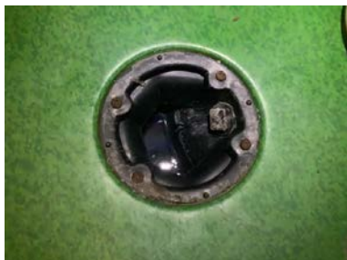
Plastsluk, og vinylbelegget er ført under slukets klemring.
