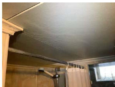
Fuktskadet himlingsplate.
