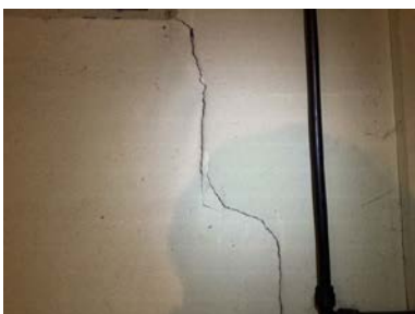
Eksempel på innvendig skråriss.
