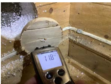
Hulltaking, og baksiden av panel måles tørr.
