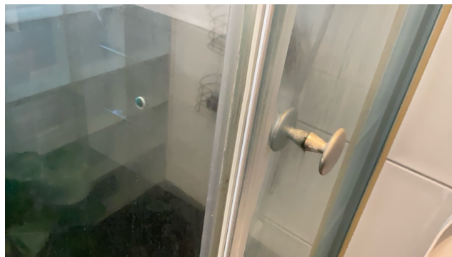
Knott på ene dusjvegg mangler.
