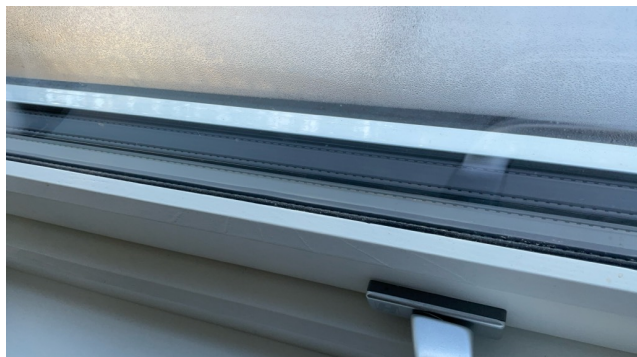
Vinduer med 3-lags glass fra 2023.
