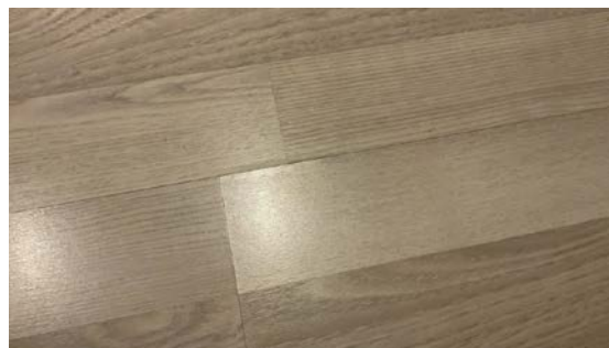
Eksempel på oppsvelling i enkelte laminatskjøter.
