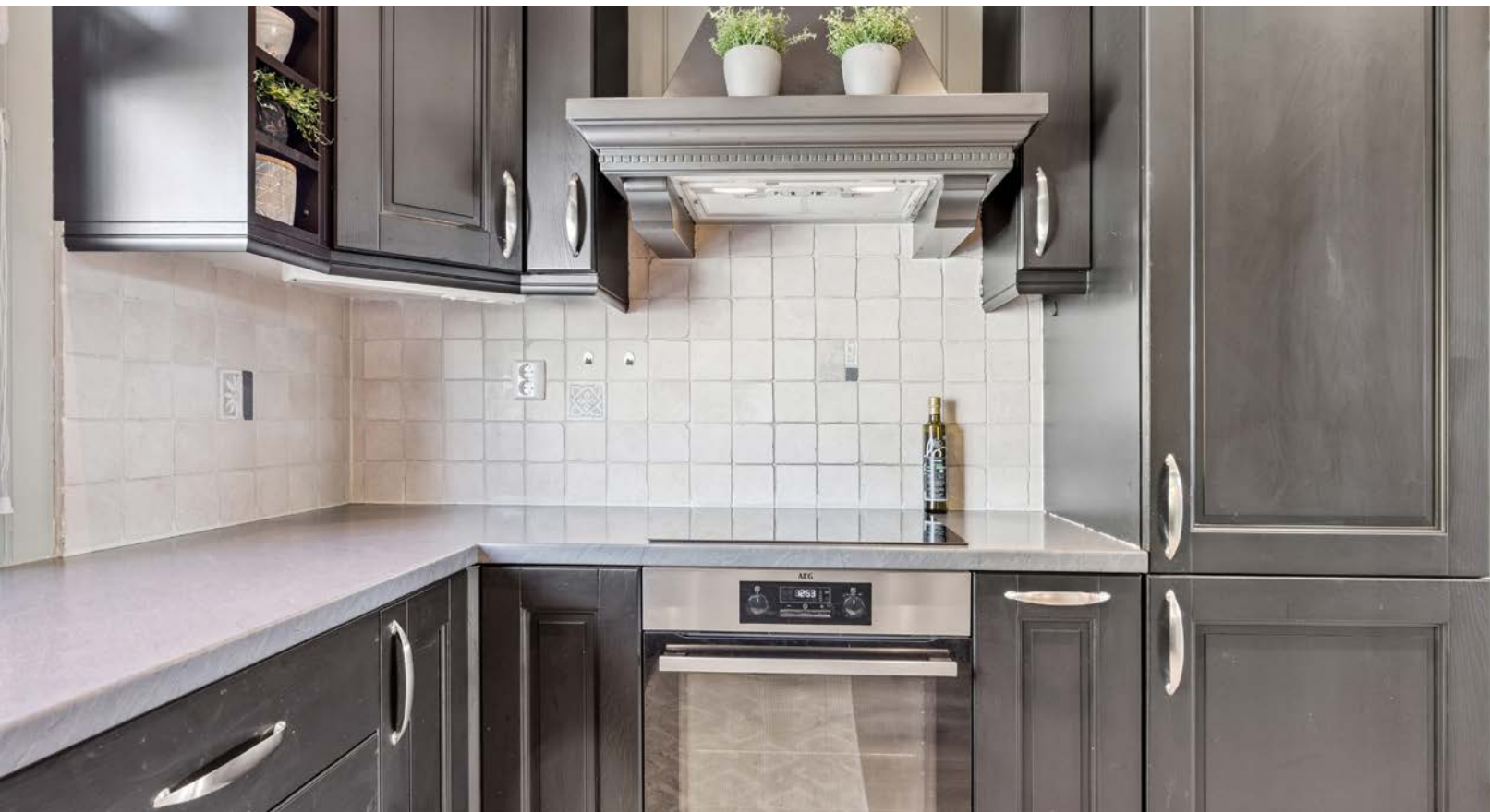
Det er montert fliser mellom over- og underskap.
