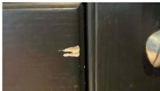
Eksempel på skader/hakk i kjøkkenfronter.
