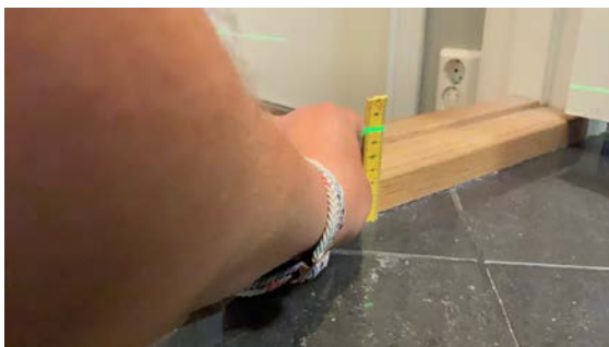
Det er målt 7cm på gulv ved terskel.
