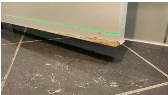
Eksempel på svellskader i dørblad.
