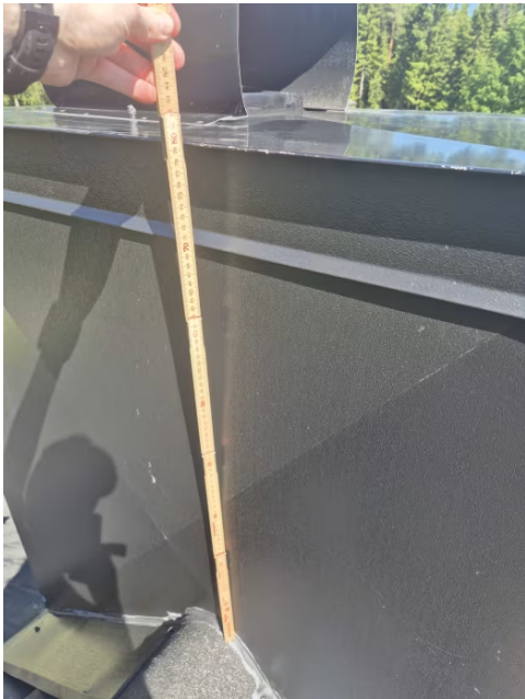
Viser målt høyde på pipe over tak.
