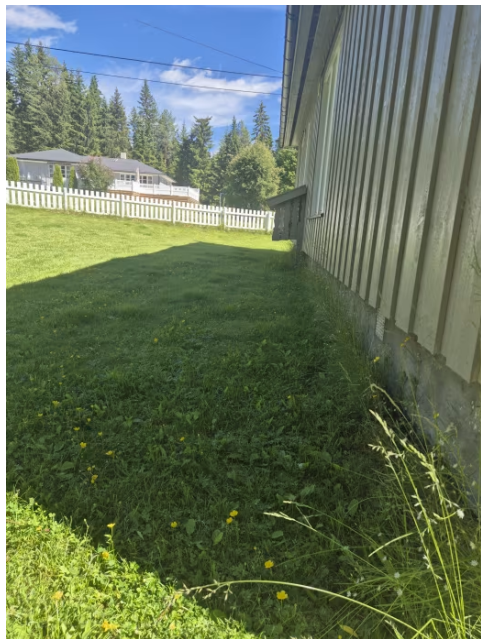
Viser område med fall på terreng mot grunnmur.
