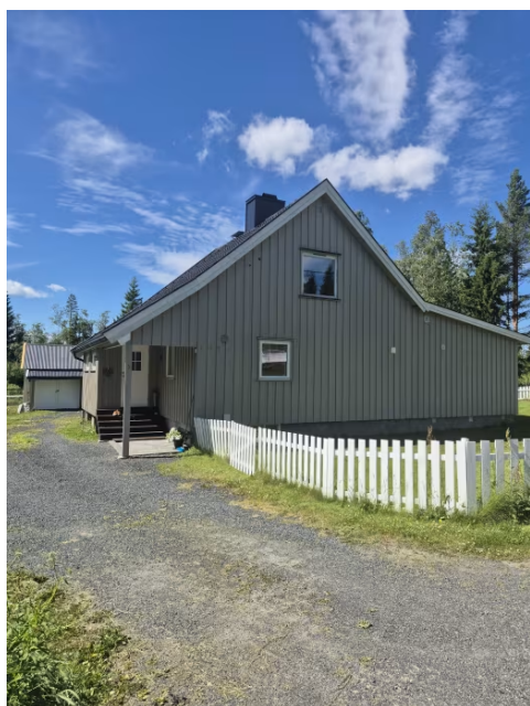
Viser takkonstruksjon, ingen tegn til skjevheter i konstruksjonen.
