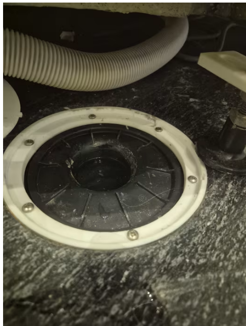
2Viser sluk under dusjkabinett med vannlås.
