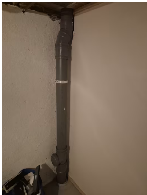
Viser plassering av stakeluke i kjeller.
