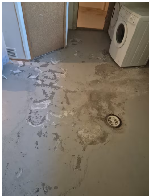
Viser ekspempel av område med mineralutslag (salt/kalkutsalg).
