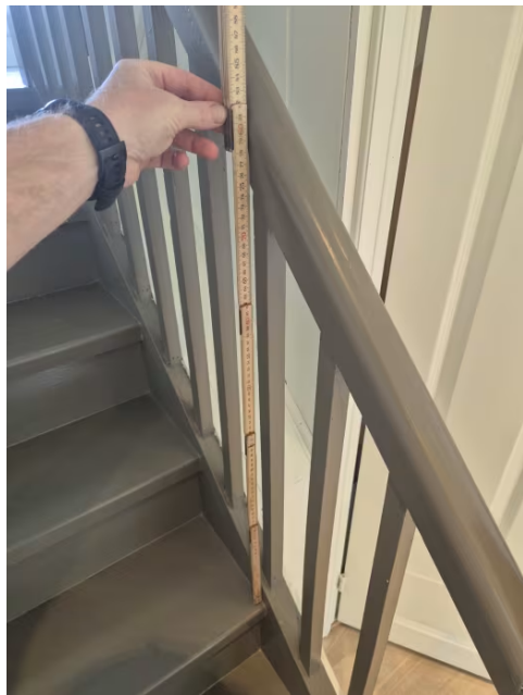
Viser målt rekkverkshøyde trapp 2. etasje.
