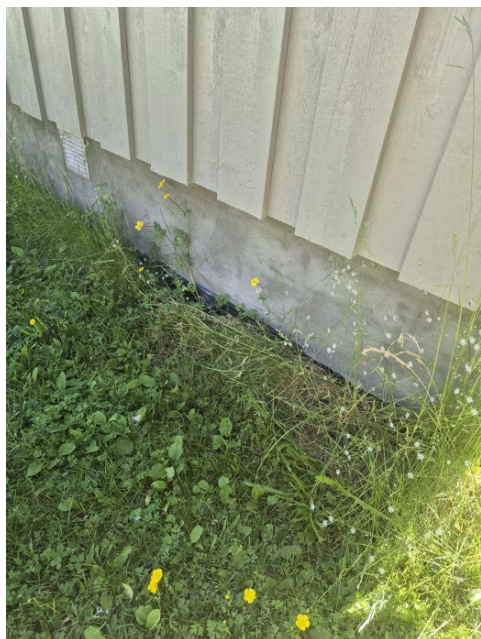
Viser etablert grunnmursplast og topplist, grunnmursplast og topplist bør være etablert over terrengnivå.
