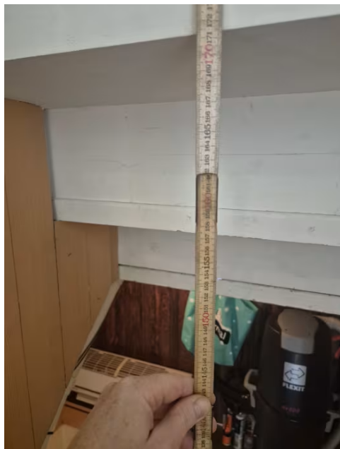
Viser målt frihøyde trapp kjeller.
