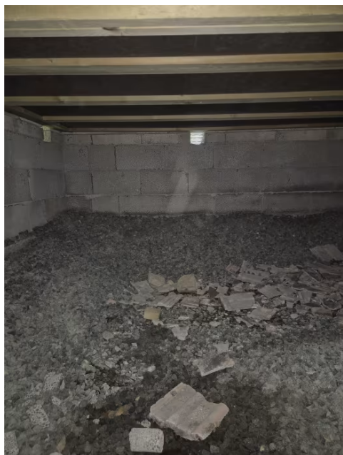
Viser del av krypkjeller.
