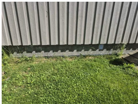
Viser etablert grunnmursplast og topplist, grunnmursplast og topplist bør være etablert over terrengnivå.
