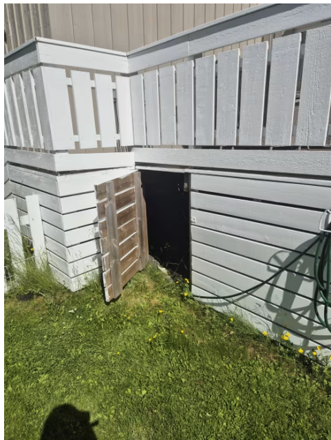
Viser tilkomst til krypkjeller under terrasse.
