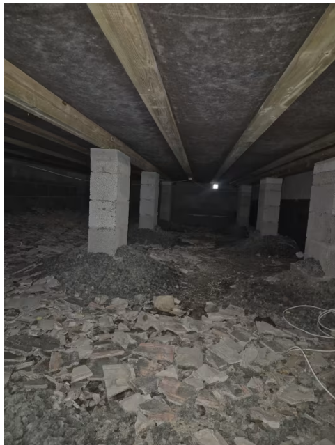
Viser del av krypkjeller.
