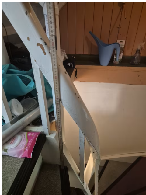
Viser målt rekkverkshøyde trapp kjeller.
