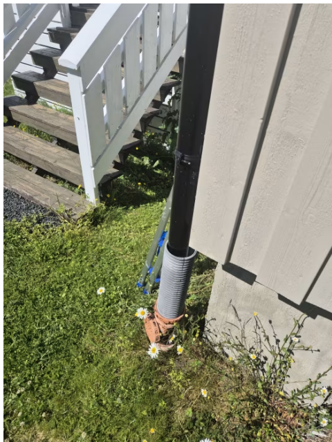
Viser nedløpsrør ført videre til lukket drenssystem.
