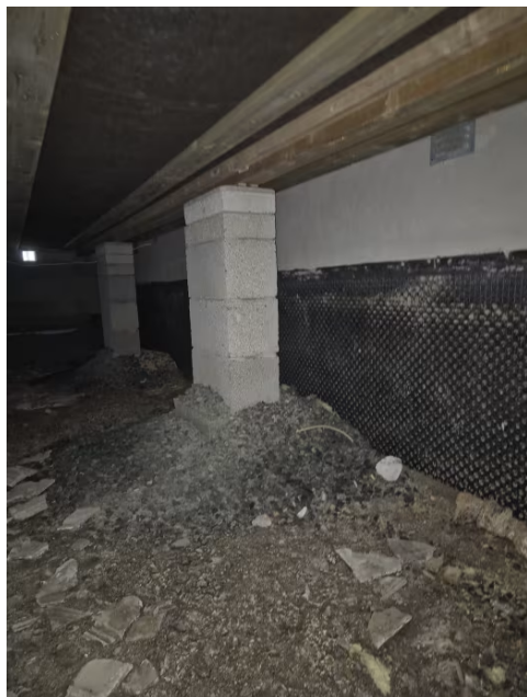
Viser del av krypkjeller mot kjeller.
