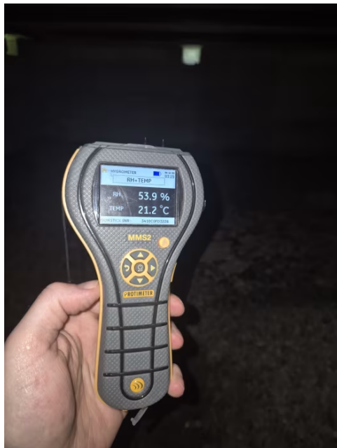
Vise måling av relativ fuktighet (RF) i kryprommet, måling viser 53,9 %.
