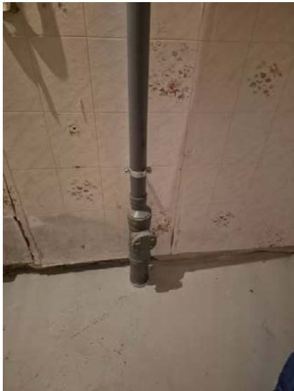
Viser plassering av stakeluke i kjeller.
