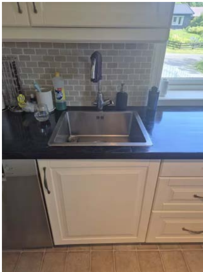
Viser foliert benkeplate og plassering kum.
