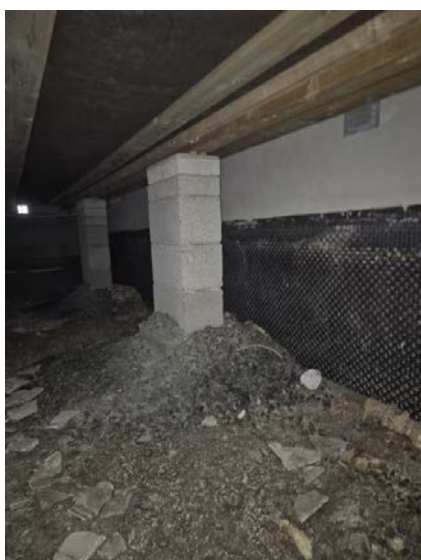
Viser del av krypkjeller mot kjeller.
