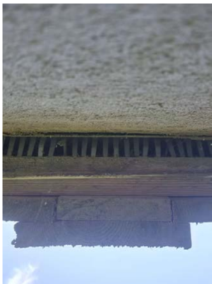
Viser tetting mot mos ved bruk av lusing/kloss.
