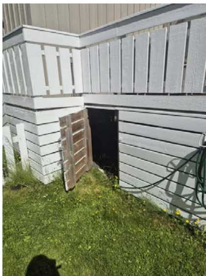
Viser tilkomst til krypkjeller under terrasse.
