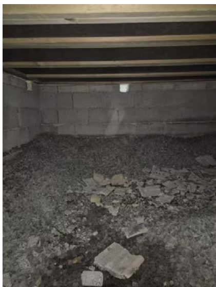
Viser del av krypkjeller.
