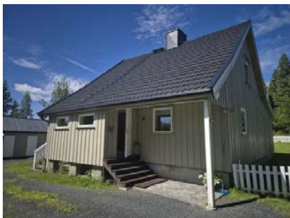
Viser takkonstruksjon, ingen tegn til skjevheter i konstruksjonen.
