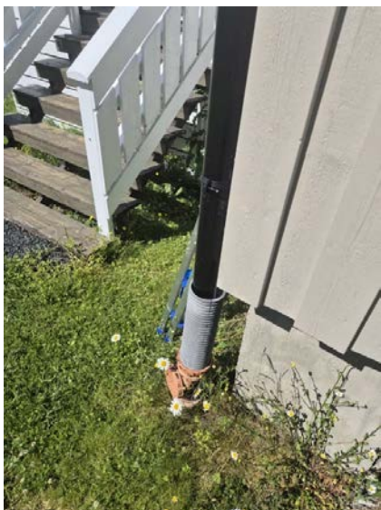
Viser nedløpsrør ført videre til lukket drens-system.
