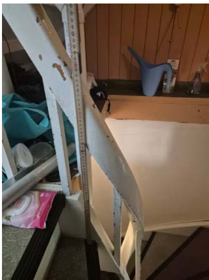
Viser målt rekkverkshøyde trapp kjeller.
