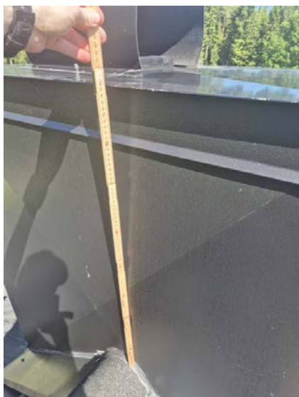
Viser målt høyde på pipe over tak.
