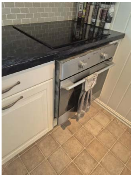
Viser stekovn som ikke er skrudd fast i innredning.
