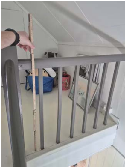
Viser målt rekkverkshøyde trapp 2. etasje.
