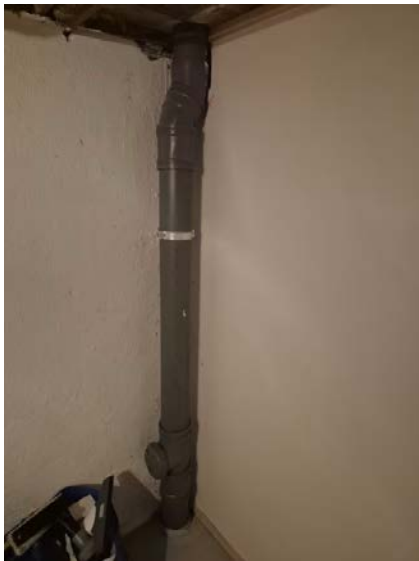
Viser plassering av stakeluke i kjeller.
