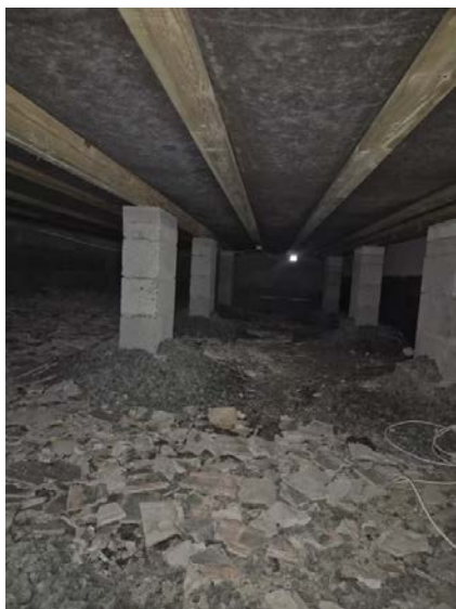
Viser del av krypkjeller.
