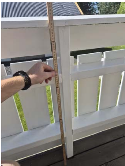
Viser rekkverkshøyde, høyde rekkverk målt til 91 cm.
