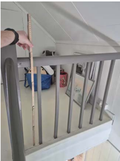
Viser målt rekkverkshøyde trapp 2. etasje.
