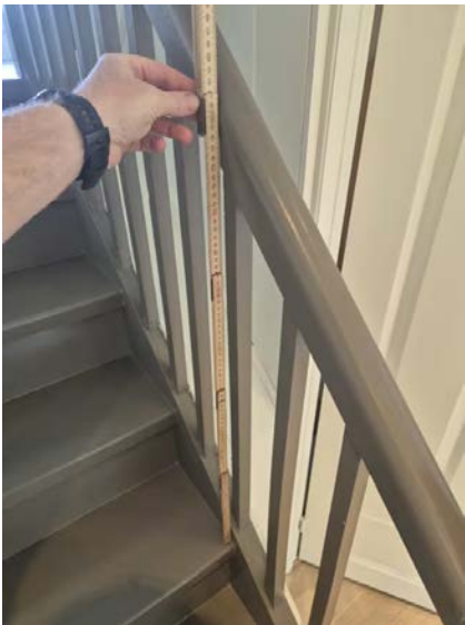
Viser målt rekkverkshøyde trapp 2. etasje.
