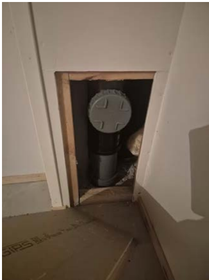
Viser plassering av stakeluke i kjeller.
