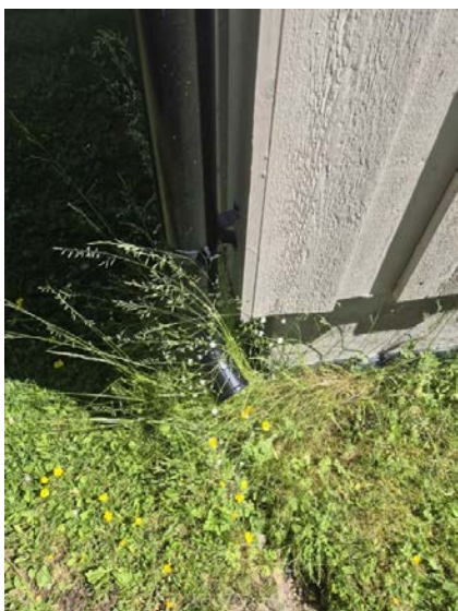
Viser nedløpsrør med etablert utkast og terrengforhold med fall vekk fra grunnmur.
