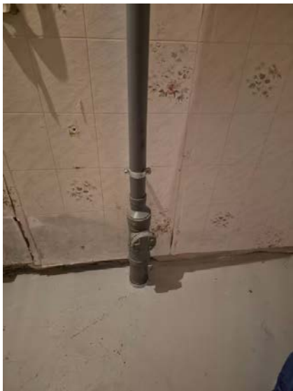
Viser plassering av stakeluke i kjeller.
