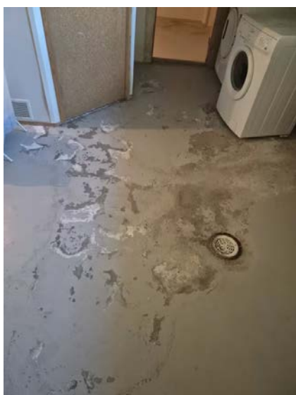
Viser eksempel av område med mineralutsalg (salt/kalkutsalg).
