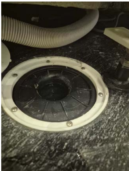
2Viser sluk under dusjkabinett med vannlås.
