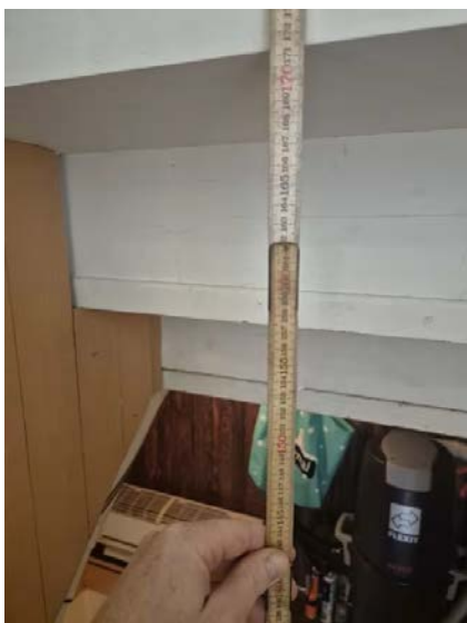
Viser målt frihøyde trapp kjeller.
