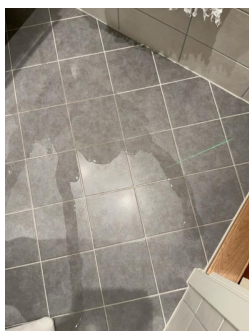
Vanntest: Vann renner mot terskel før vannet renner til sluk.
