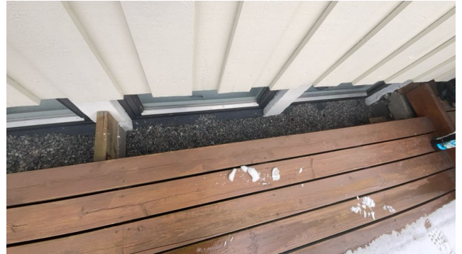
Vinduer lavt i terreng ved terrasse
