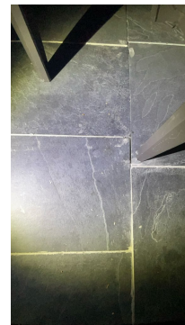
Løsninger i fuger flisfelt under vedovner
