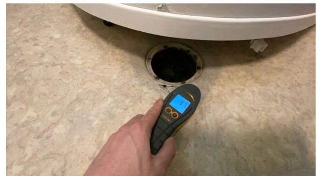
Fuktsøk rundt sluk
