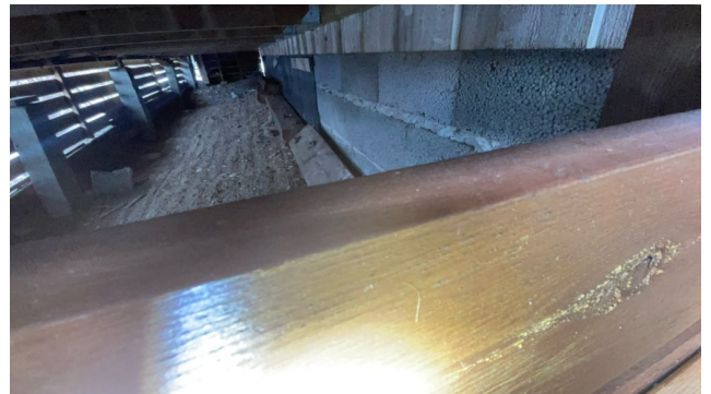
Fuktsperre over terreng under veranda stopper ca. midt på.
