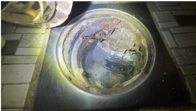
Skadet sluk/klemring
